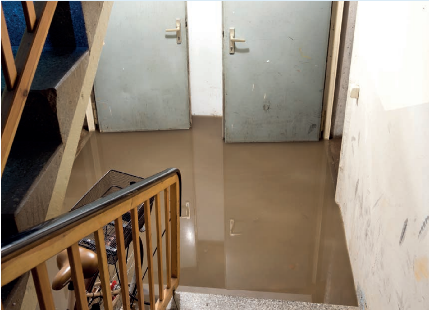
Abb. 37 – Kellerüberflutung nach Rückstau
