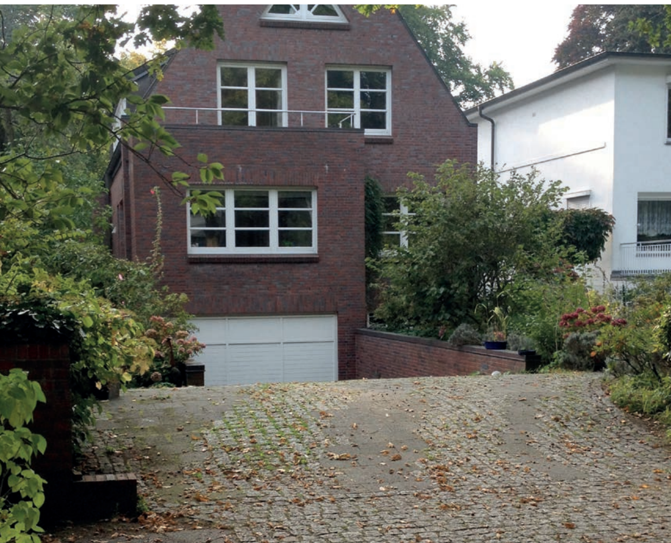
Abb. 16 – Garagenzufahrt mit Schutzschwelle
