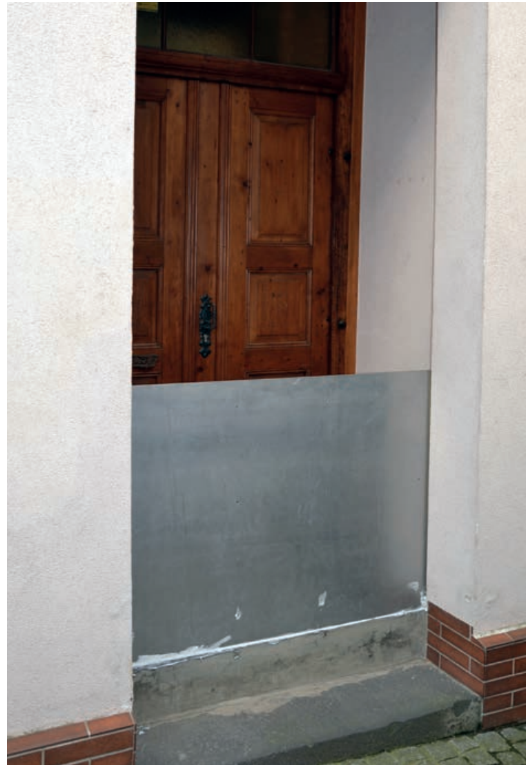
Abb. 25 – Mobile Schutzbarriere
