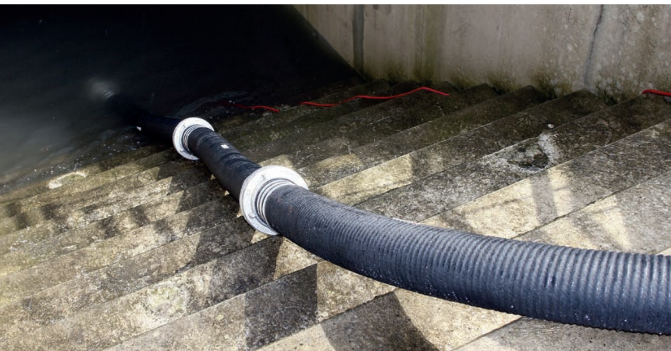
Abb. 2 – Abpumpen eines überfluteten Treppenbereichs
