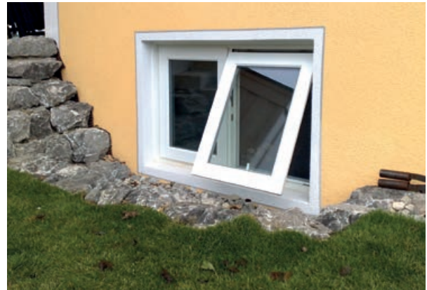
Abb. 27 – Druckwasserdichte Fenster
