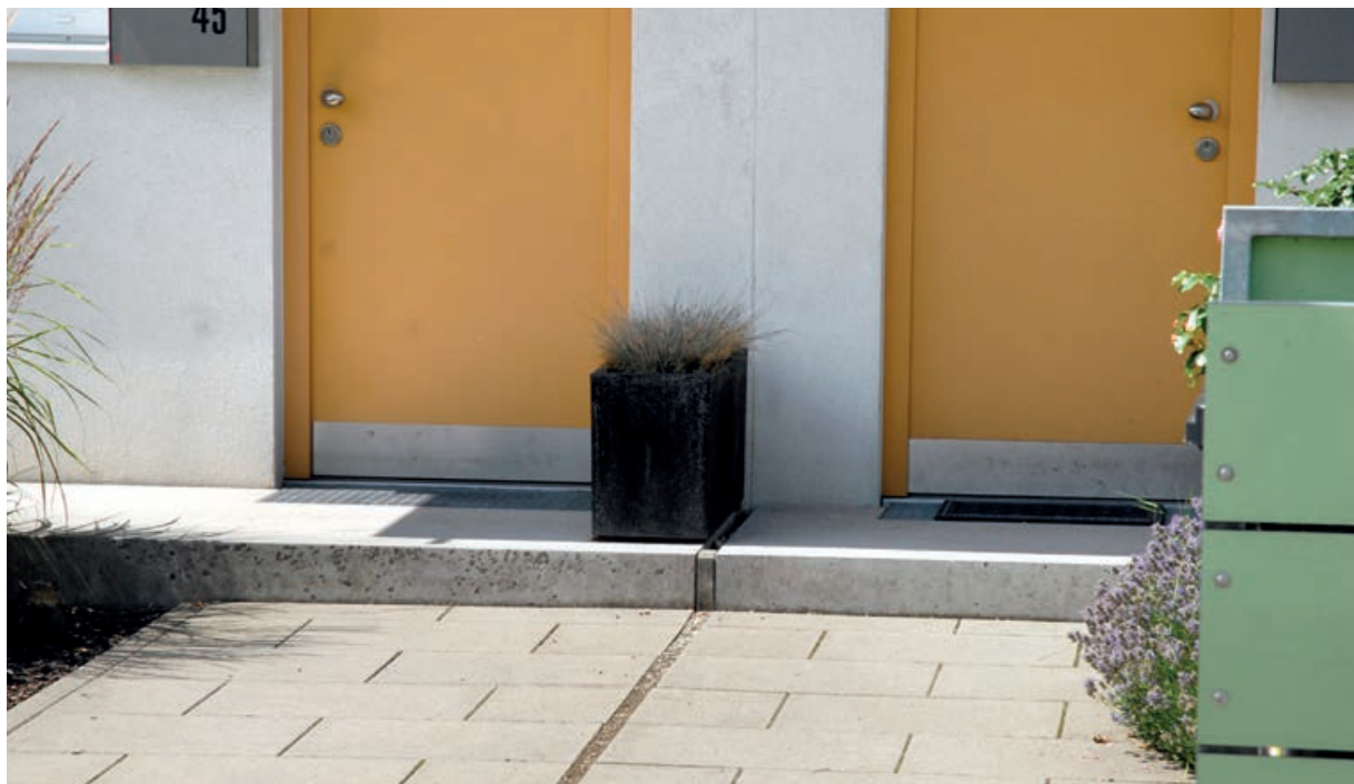
Abb. 22 – Aufkantung am Gebäudezugang
