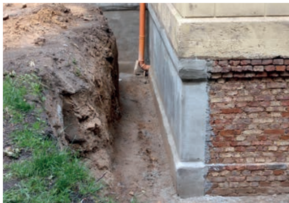
Abb. 31 – Wasserdichter Sperrputz
