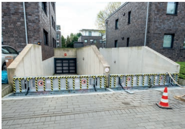
Abb. 24 – Automatisch schließendes Klappschott
