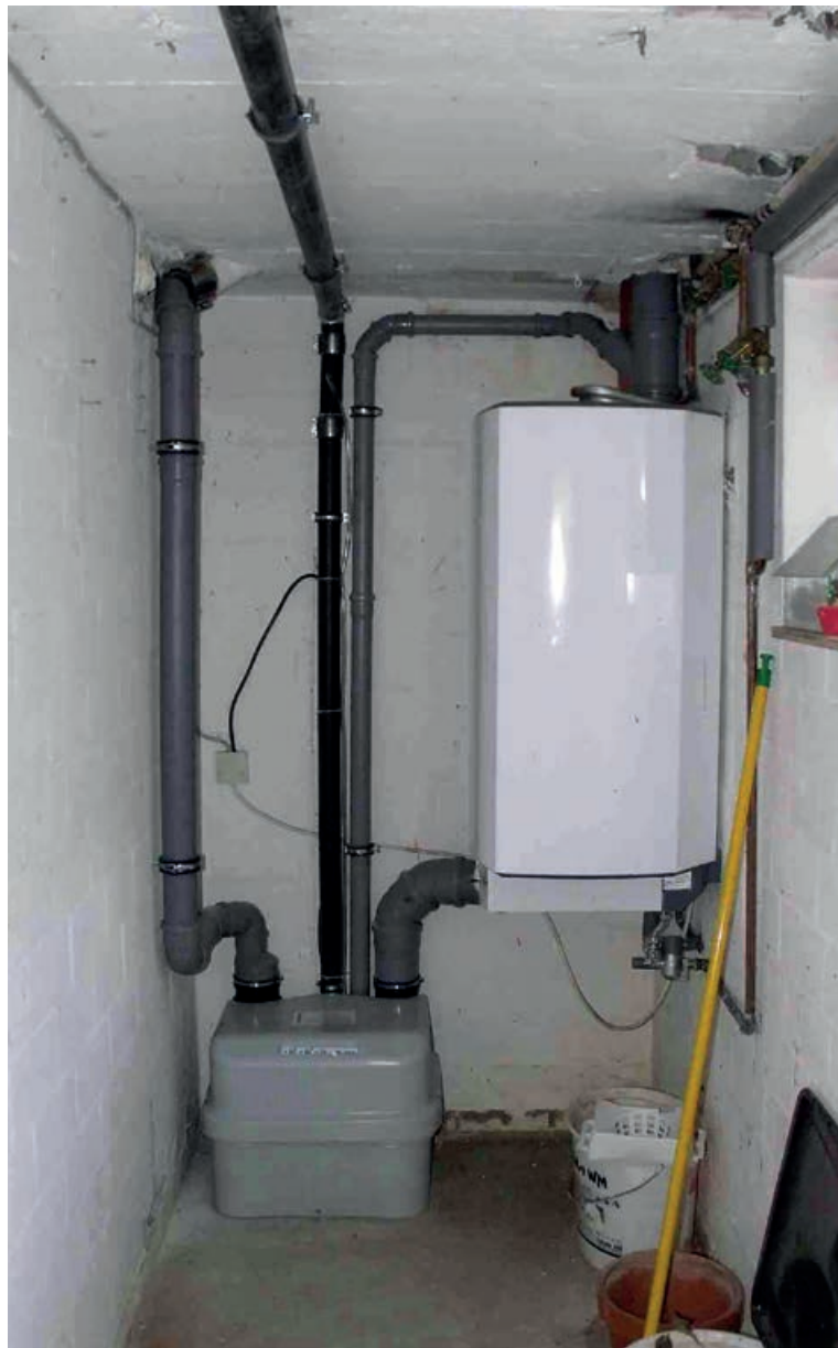
Abb. 43 – Hebeanlage
