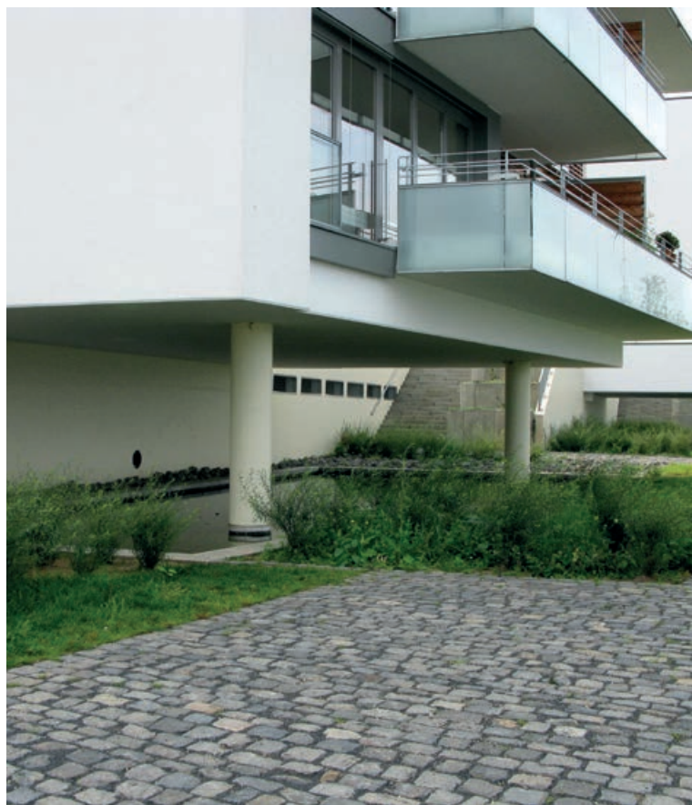
Abb. 34 – Aufständering eines Gebäudes
