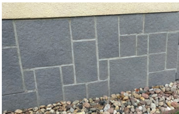
Abb. 32 – Abdichtung mit Steinzeugfliesen
